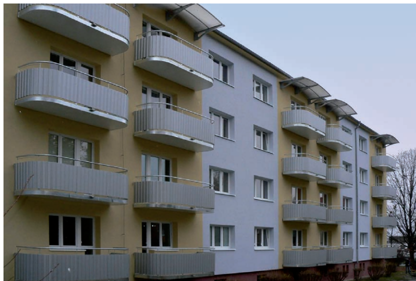
Kompletní revitalizace s novými balkóny
