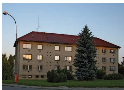
Konstrukce domů z plných cihel je staticky většinou zcela v pořádku. Tepelněizolační vlastnosti v porovnání s moderními materiály ale zasostávají
