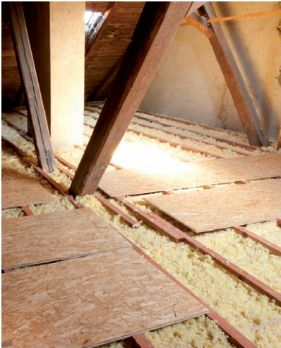
Stropní systém MAGMARELAX® zafoukaný minerální izolací
