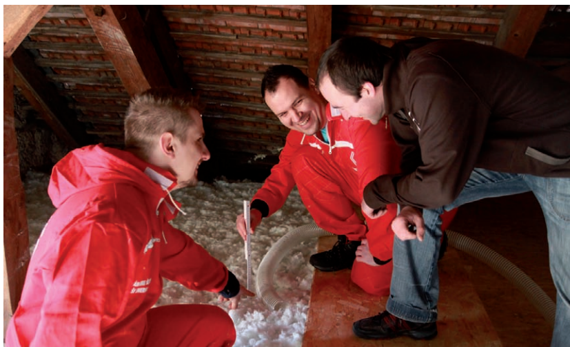
Závěrečná kontrola výšky izolace s klientem
