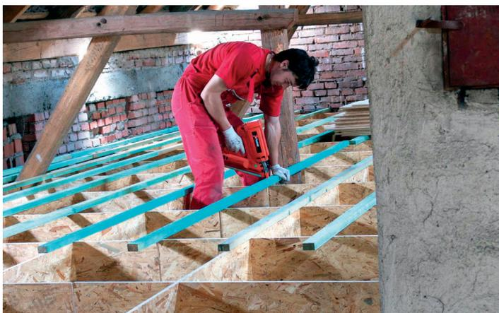
Nyní tento způsob bydlení opět ožívá. Jen se více investuje do podlahy půdy. Nové technologie umožňují postavit naprosto rovnou podlahu a tu zaizolovat. Izolace zvyšuje komfort. Tlumí hluk a v zimě chrání spodní místnosti před únikem tepla. Příkladem takového řešení na míru je Stropní systém **MAGMARELAX®**.
